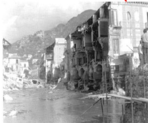
Danni agli edifici in Maiori.
