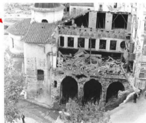
Danni agli edifici in Marina di Vietri sul Mare.
