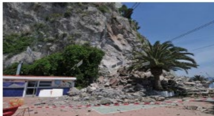
Crollo in roccia a Vietri sul Mare (SA), http://lacittadisalerno.gelocal.it/
