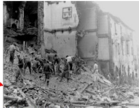
Danni agli edifici in Salerno.
